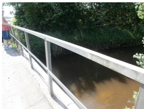
Broen over Holme Kanal ved Oved
